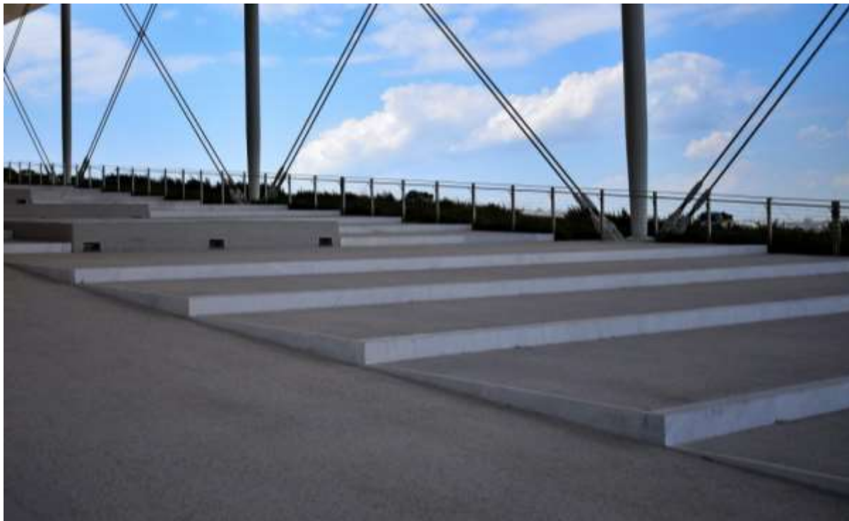
Εικόνα 4 Δάπεδο από πελεκητό μπετόν στο Κέντρο Πολιτισμού του Ιδρύματος Νιάρχος.
